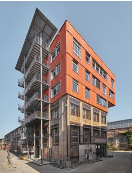
Bei der Aufstockung der ehemaligen Sulzer-Halle 118 kamen weitgehend gebrauchte Materialien zum Einsatz – auch die rote Blechfassade.
