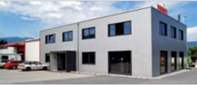
Der neu gebaute Fornax-Hauptsitz in Derendingen.
