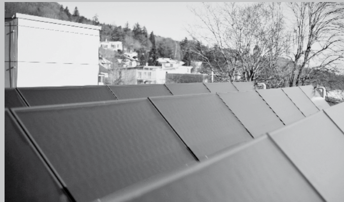
Sanierung Hallenbad Oberdorf 4515 Oberdorf (2010/2011)
