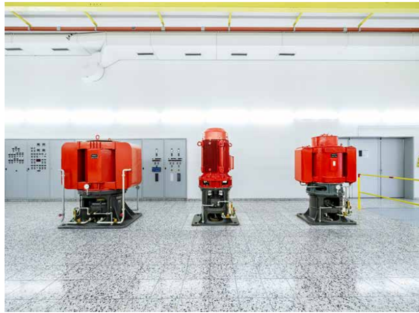
Das Pumpwerk Aarmatt befördert das Wasser in die höher gelegenen Reservoirs, die für genügend Wasserdruck sorgen.
