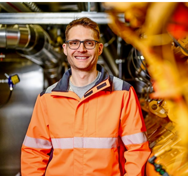
Thomas Häni und sein Team haben das neue Blockheizkraftwerk im Hybridwerk Aarmatt installiert.
