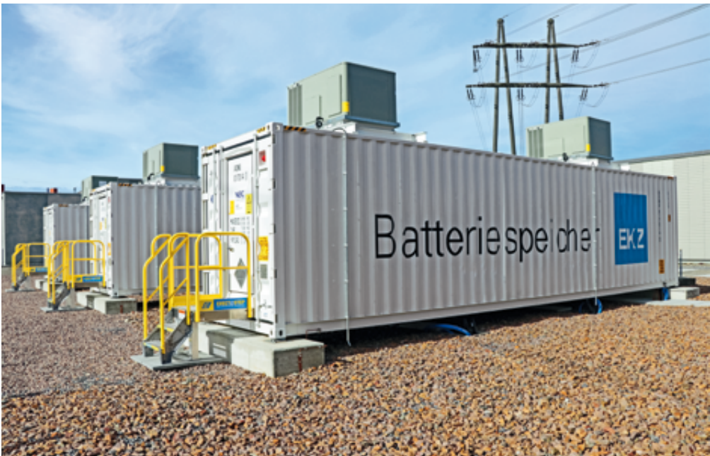
Die Grossbatterie in Volketswil wiegt insgesamt 150 Tonnen und ist in drei Containern untergebracht. Sie kann kleinste Frequenzschwankungen im Stromnetz sofort ausgleichen.
