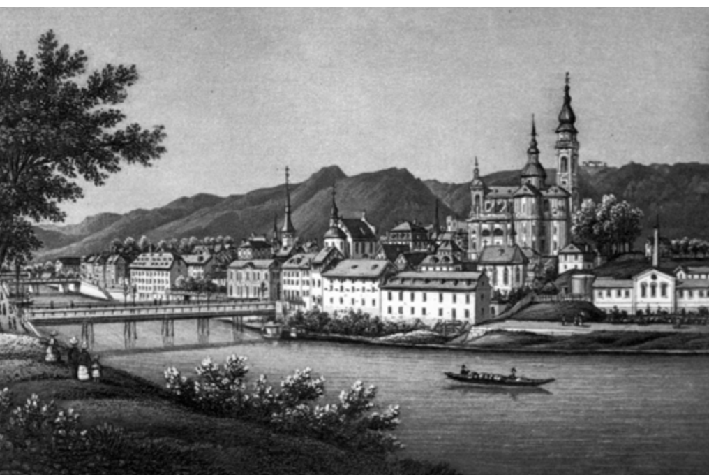
Sicht auf Solothurn mit altem Gaswerk (rechts unten im Bild)
