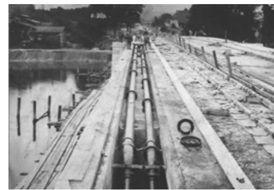
Wasser- und Gasleitung bei Bau Rötibrücke um 1925
